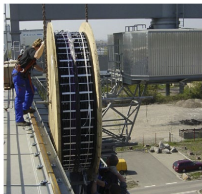
在多式联运起重机上的拖链安装
